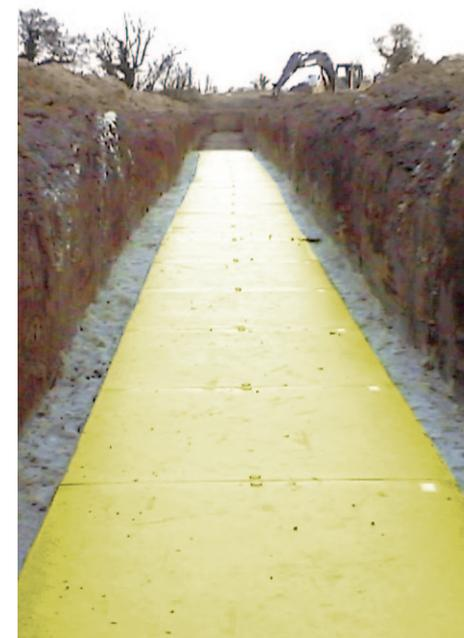
Figura 4: Lastre di protezione posate sopra a una tubatura del gas
